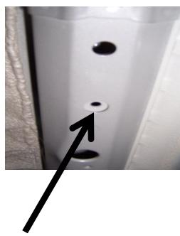
Pour agrandir, percer les trous sur la face interne des longerons, si nécessaire.
