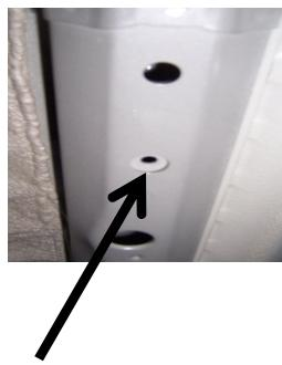
Pour les agrandir, percer les trous sur la face interne des longerons, si nécessaire.
